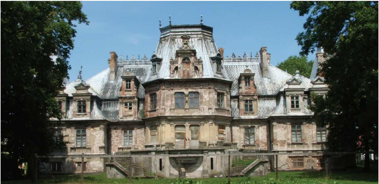
Elewacja ogrodowa (południowa) pałacu w Guzowie, fot. M. Krasucki
